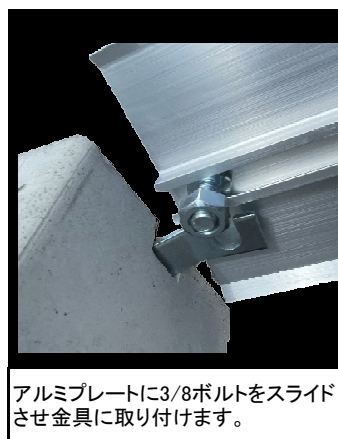
アルミプレートの位置を決めた後、ナットで固定します。
