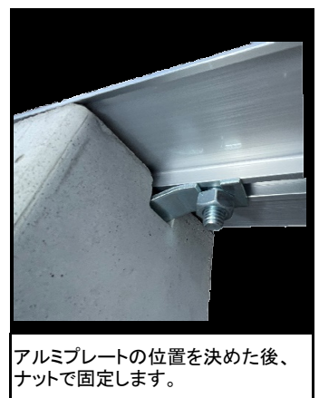
アルミプレートに3/8ボルトをスライドさせ金具に取り付けます。
